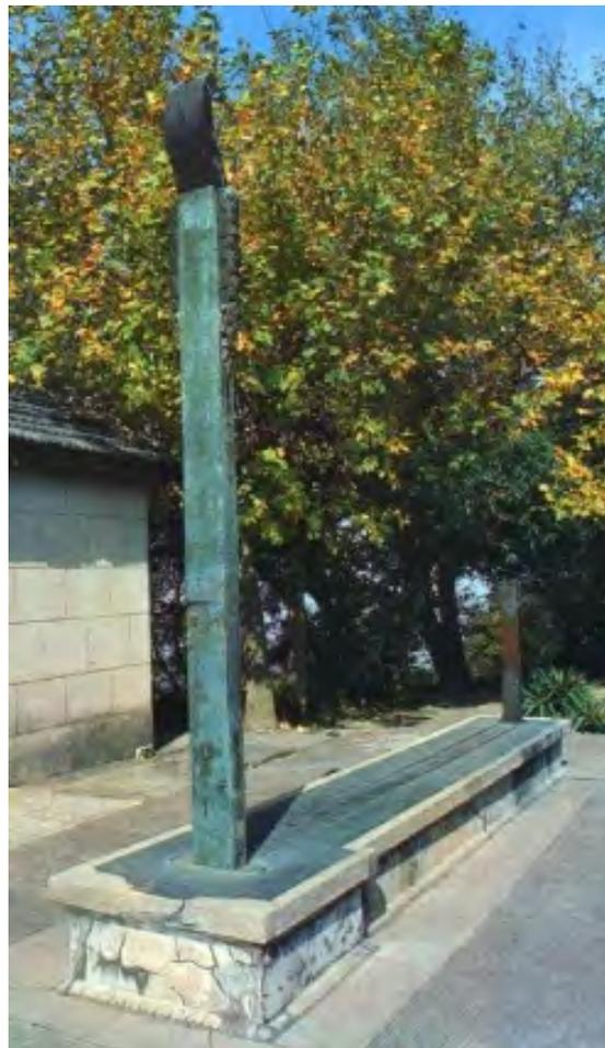
L'œilleton aménagé au sommet de la pièce de bronze rapportée en 1744 est original. Son ouverture d'un diamètre d'environ 1 cm dans sa partie la plus étroite, est pratiquée entre deux évidements en forme de troncs de cône ménageant eux-mêmes une ouverture circulaire de 6,2 cm de diamètre sur la face éclairée par le soleil et de 3, cm sur la face située à l'ombre (voir la figure ci-dessus). Cette disposition permet d'avoir un œilleton de faible diamètre dans une pièce de bronze épaisse.
