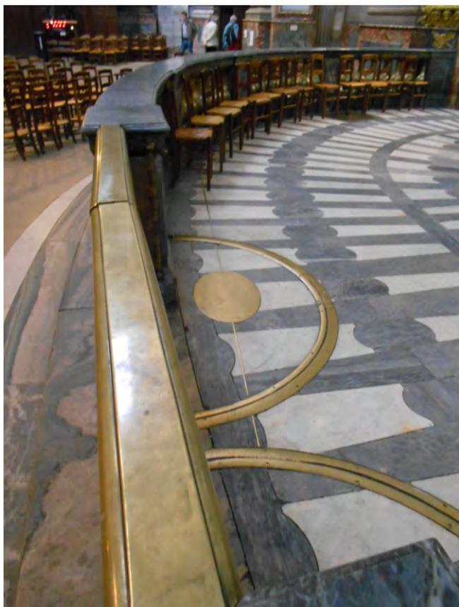
**Figure 9** – Partie de la méridienne au voisinage des équinoxes, surélevée dans le chœur de l'église. Un ovale marque l'image du Soleil à cet instant. On notera que la bande est laiton s'arrête brutalement. Les deux arceaux en laiton qui coupent la méridienne servent de guide aux deux petites portes qui permettent d'accéder au chœur.
