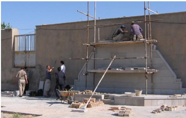
Fig 2 Construction du mur en marbre gris sur lequel va être tracé le cadran solaire.
