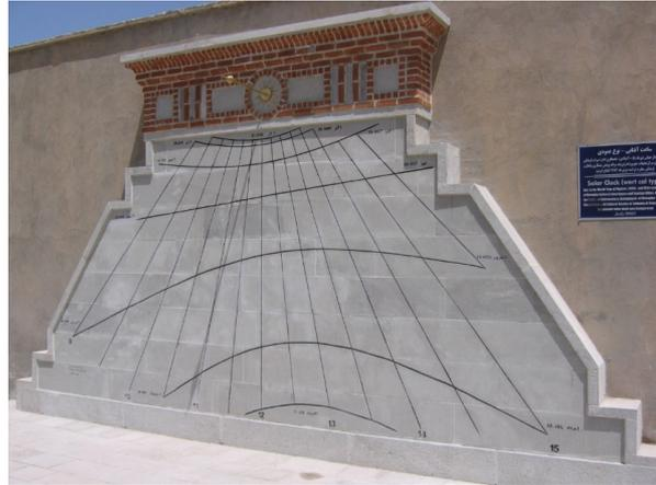
Fig. 7 Le cadran vertical de Maragha terminé. L'heure est indiquée par l'extrémité de l'ombre du style droit.
