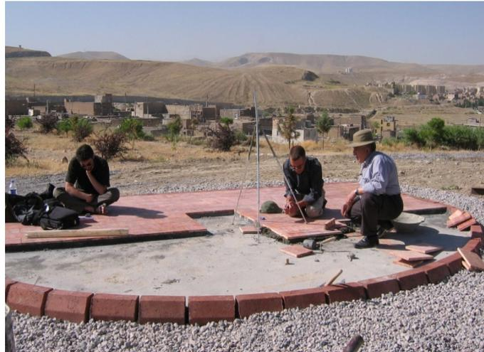
Fig. 4bis Matérialisation de l'axe Est-Ouest sur le socle à l'aide de l'ombre d'un fil à plomb. De gauche à droite : M. Goutaudier, D. Savoie, Ali Ajabshirizadeh.
