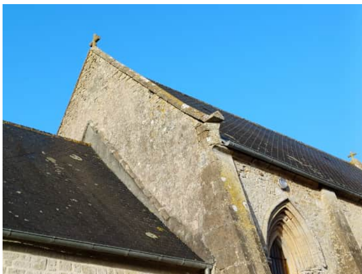
FIG. 4 – Mur pignon du chœur, nef à gauche, chœur et portail du chœur à droite.
