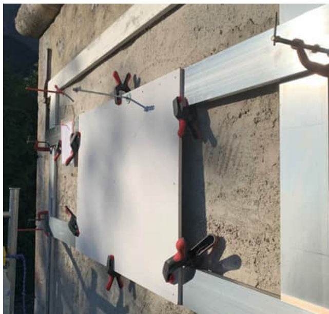
FIG. 2 – Table d'enregistrement d'une courbe diurne en situation sur l'Église de Biviers, Isère. Elle est ici fixée (exceptionnellement!) sur les règles en aluminium du coffrage de la table du futur cadran. Matériau Forex Classic 80 cm×60 cm, épaisseur 1 cm. Crédit photo : D. Cottier, 2020.
