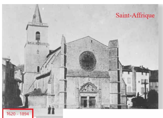
(a) La quatrième église de la ville construite au 17 e
