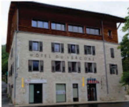
Hôtel du Vercors Façade Est
