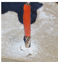
Perçage des trous de fixation
