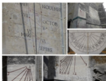
Restauration sur édifice
