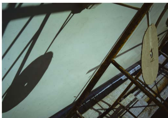
▲ Style droit temporaire muni d'un œilleton
