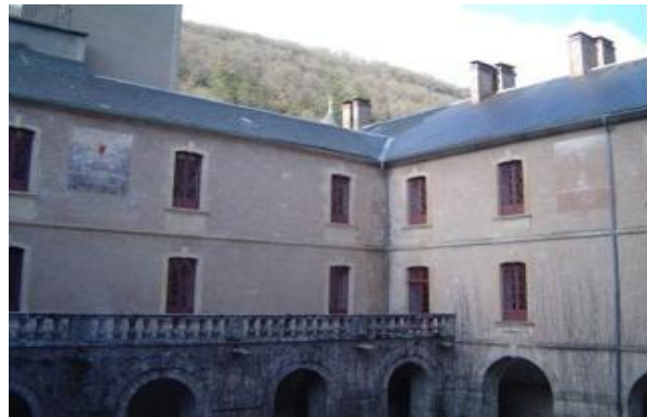
Une abbaye (plusieurs cadrans, bâtiment principal et communs.
