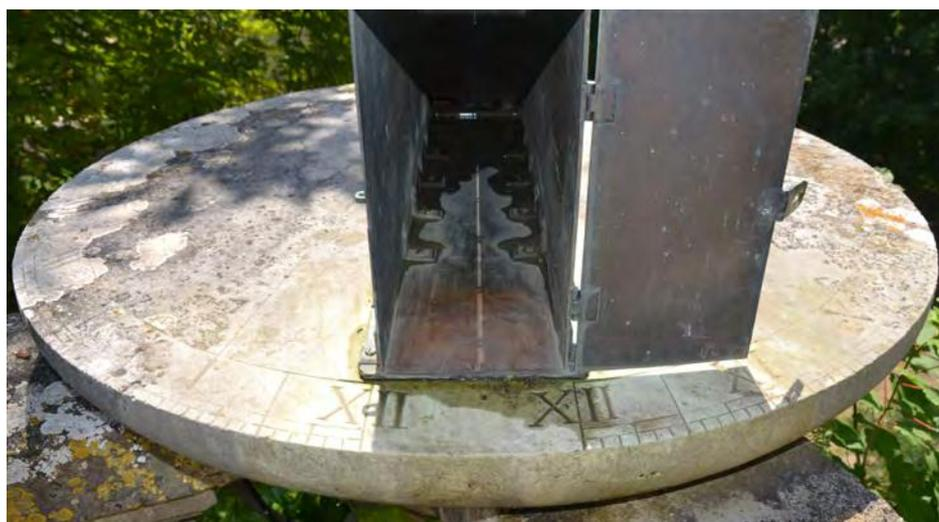
**FIGURE 12** – Chambre méridienne de Claude Langlois située au château de la Roche Guyon (Val d'Oise). Le faisceau de lumière ponctué de trous est bien visible.
